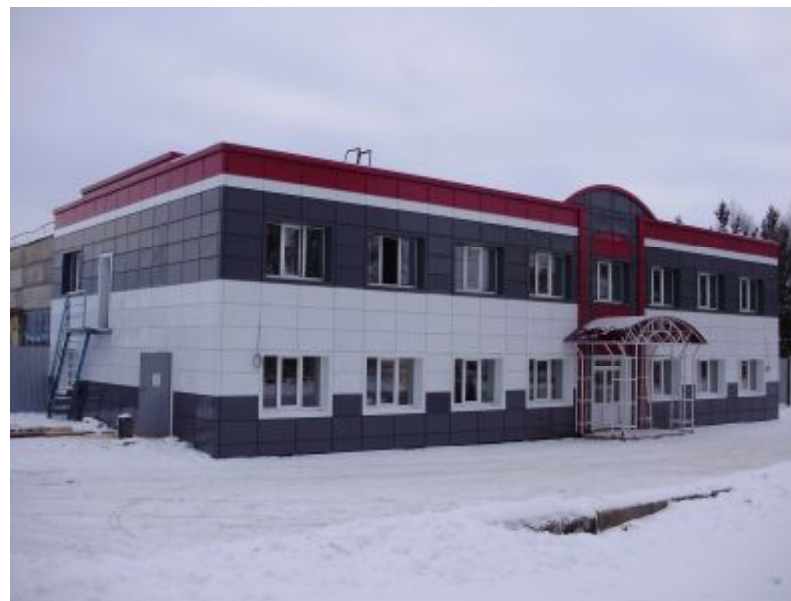
Офисное здание, г.Белорецк, Республика Башкортостан
