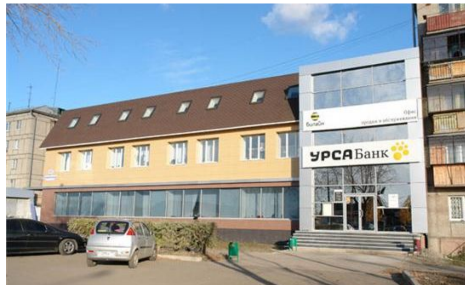
Офисный центр, г. Магнитогорск
